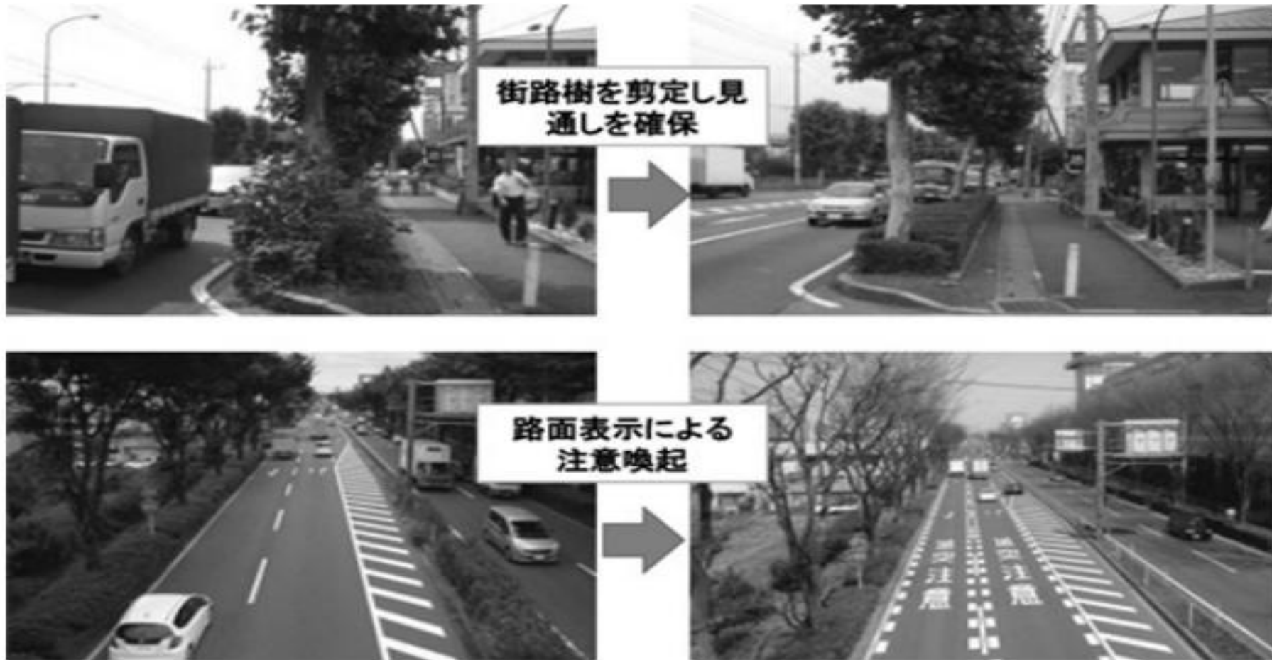
Fig.2 車両プローブデータを活用した安全対策 1)
